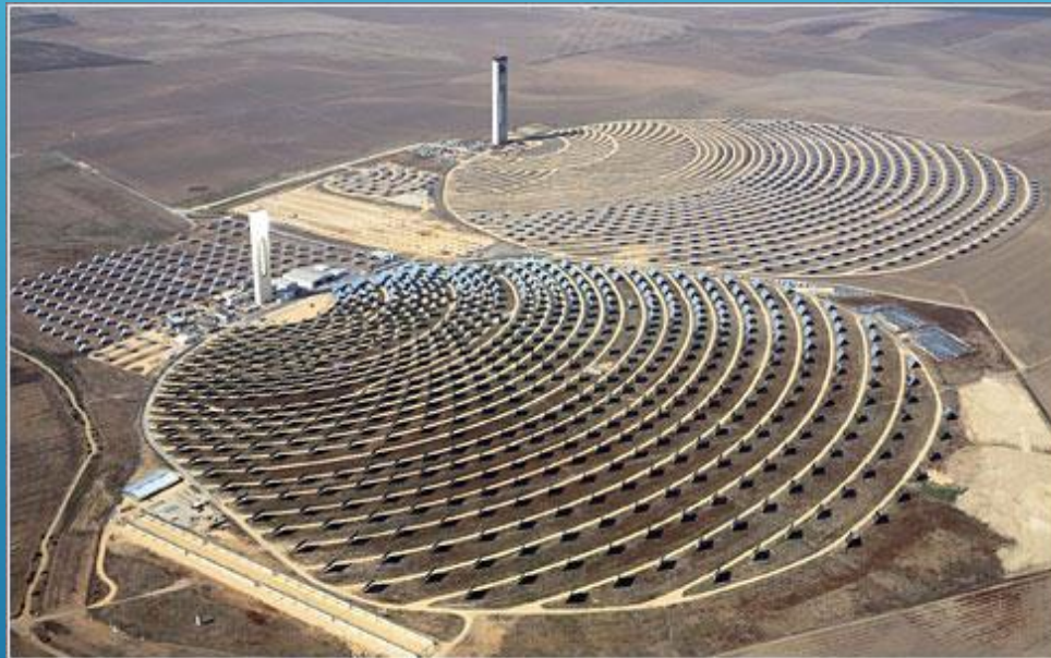
Planta Solar PS20 – Sevilla, España Capacidad 20 MW
