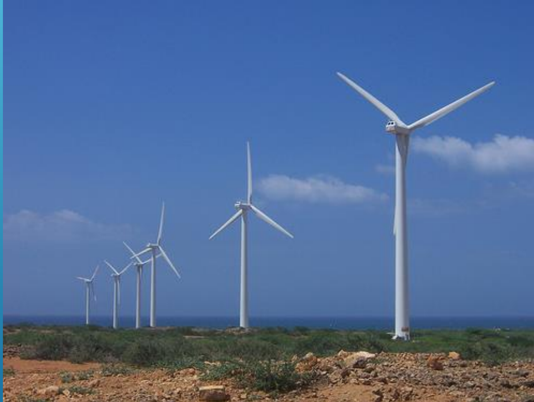
Parque Eólico Jepirachi - Guajira Capacidad 19.5 MW
